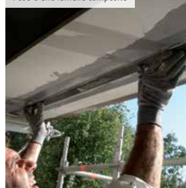
Pose d'une lamelle composite
