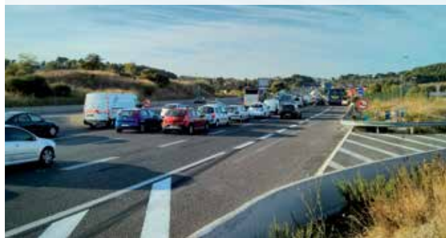
Voie réservée bus sur l'autoroute A51 entre Aix-en-Provence et Marseille au niveau de la zone Plan de Campagne
