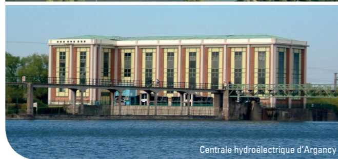
Centrale hydroélectrique de Jouy-aux-Arches
