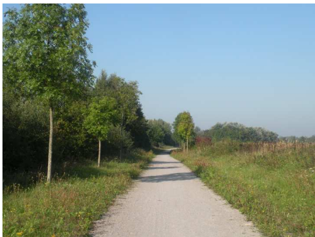
Exemple de voie verte en stabilisé Source : Verdi
