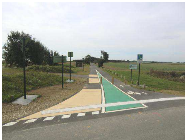
Exemple de voie verte en béton Source : Scots
