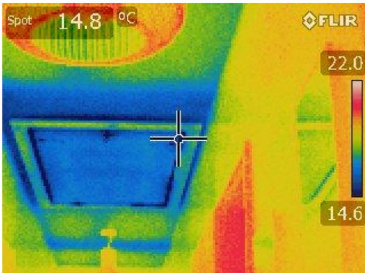
Infiltration au niveau d'une trappe (+ défaut d'isolation)
