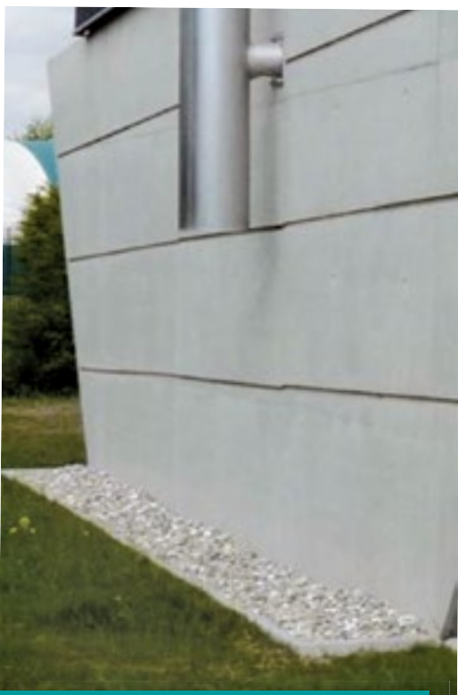
Station d'interconnexion de La Wantzenau
